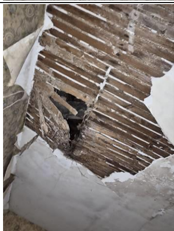
Photo n° PhTer010 Localisation : Rez de chaussée - Salon Ouvrage : Plafond (P1) - Lattis bois Parasite : Présence d'indices d'infestation de termites Indices : galeries-tunnels, bois d'apparence feuilleté, dégradation du bois
