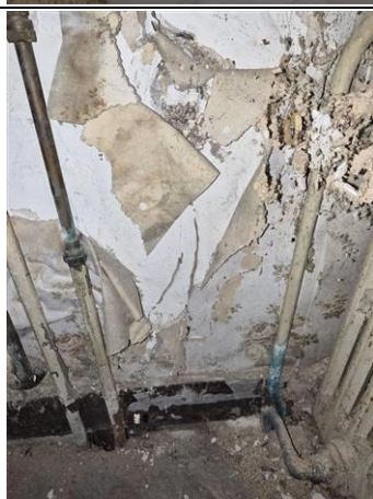
Photo n° PhTer011 Localisation : Rez de chaussée - Chambre Ouvrage : Mur - A, B, C, D - plâtre et tapisserie Parasite : Présence d'indices d'infestation de termites Indices : présence de cordonnets
