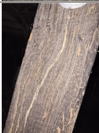
Photo n° PhTer003 Localisation : Sous-Sol - Cave Ouvrage : Poteau - Bois Parasite : Présence d'indices d'infestation de termites Indices : dégradation du bois, présence de cordonnets
