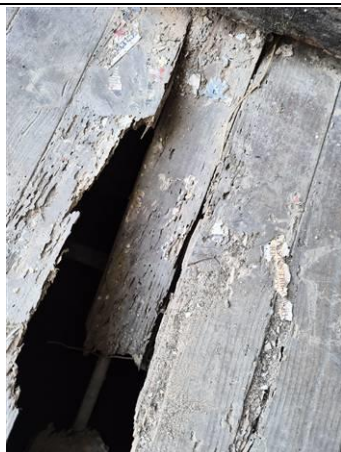
Photo n° PhTer004 Localisation : Rez de chaussée - Entrée Ouvrage : Sol - plancher bois Parasite : Présence d'indices d'infestation de termites Indices : bois d'apparence feuilleté
