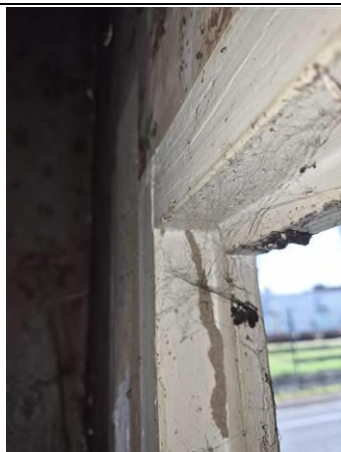
Photo n° PhTer012 Localisation : Rez de chaussée - Chambre Ouvrage : Porte (P1) - A - bois et peinture Parasite : Présence d'indices d'infestation de termites Indices : présence de cordonnets
