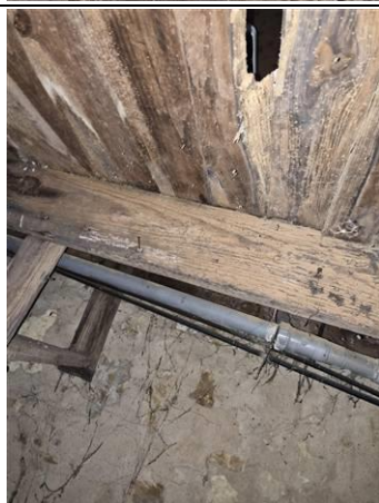
Photo n° PhTer002 Localisation : Sous-Sol - Cave Ouvrage : Plafond - Solives et plancher bois Parasite : Présence d'indices d'infestation de termites Indices : bois d'apparence feuilleté, dégradation du bois
