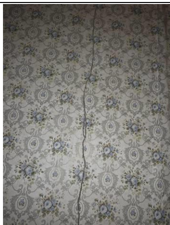
Photo n° PhTer009 Localisation : Rez de chaussée - Salon Ouvrage : Mur - A, B, C, D - plâtre et Tapisserie Parasite : Présence d'indices d'infestation de termites Indices : présence de cordonnets
