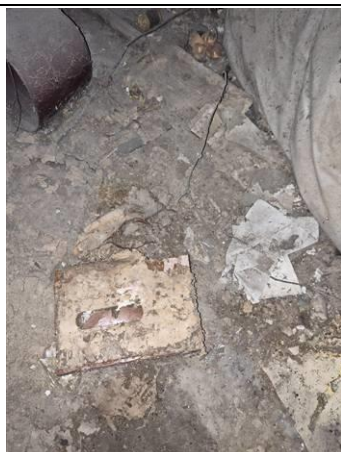
Photo n° PhTer001 Localisation : Sous-Sol - Cave Ouvrage : Sol - Papier, carton et bois Parasite : Présence d'indices d'infestation de termites Indices : Dégâts d'apparence feuilleté
