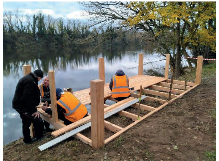
Ponton PMR en cours de montage
