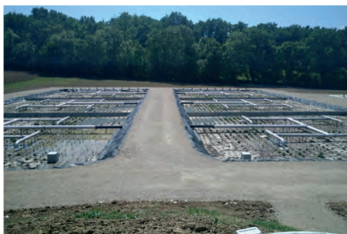
Réhabilitation station épuration Sigoulès-et-Flaugeac
